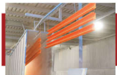
Sơn tĩnh điện Automatic powder coating
