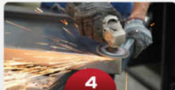
4 Vệ sinh công nghiệp Industrial hygiene
