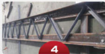
4 Quá trình lắp ráp thử Trial assembly process
