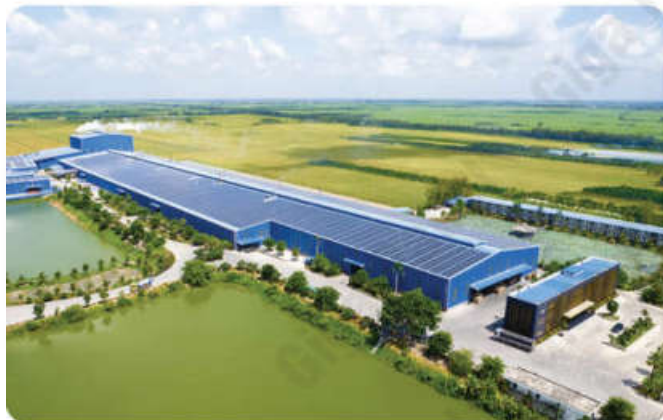
NHÀ MÁY GẠCH MEN HÀ THANH Ha Thanh Ceramic Tile Factory
