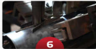
6 Quy trình hàn hồ quang chìm Light pole shut welding machine process
