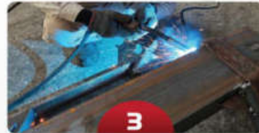
3 Quy trình hàn Welding process
