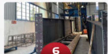
6 Quy trình chà mài - phun bi Grinding process - ball spraying
